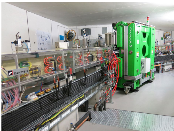
Wnętrze tunelu pierścienia akumulacyjnego w NCPS SOLARIS
